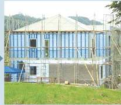
第三周：外部結構完成
