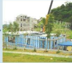
第一周：二樓樓板施工
