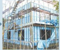
二樓壁板施工
