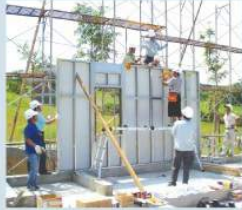
基礎和一樓壁板施工
