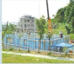
一樓壁板完成
